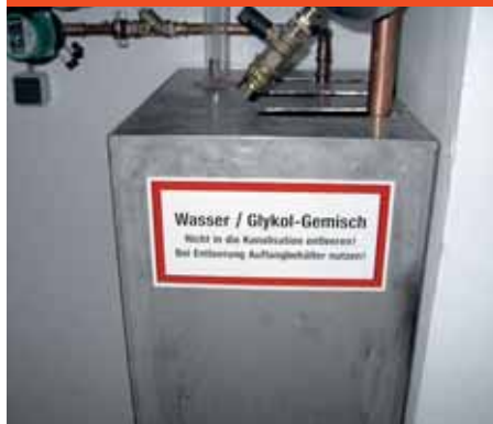
Rys. B.3.5-10 Zbiornik magazynujący
