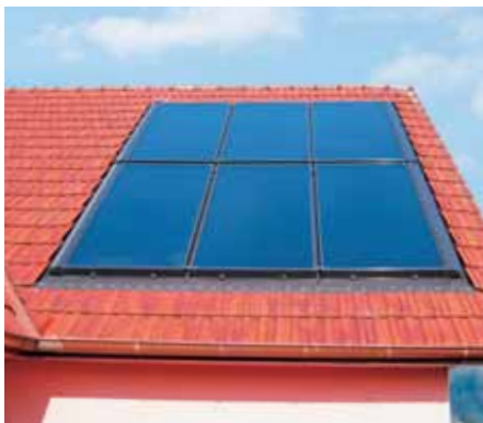
Fot. B.1.6–8 Integracja z dachem
