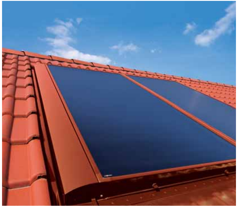
Fot. B.1.7-3 Integracja z dachem kolektora płaskiego
