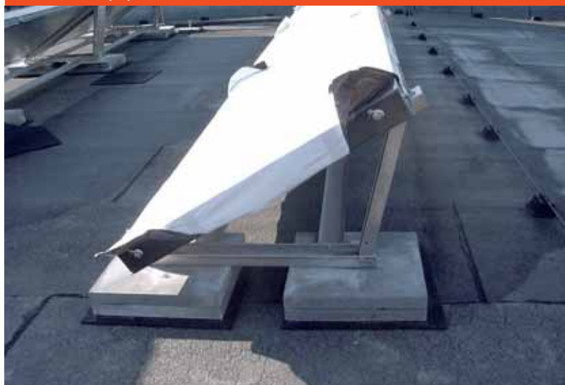
Fot. E.1.2-1 Przykrycie kolektora
