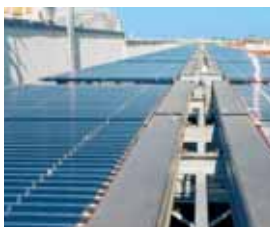
Fot. B.1.6-12 Montaż na dachu płaskim w pozycji leżącej
