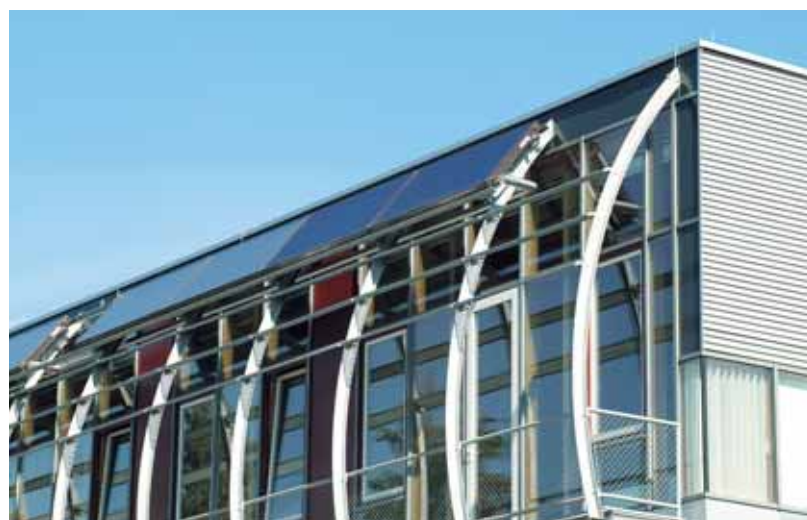
Fot. B.1.7-2 Montaż kolektorów jako roleta, baldachim
